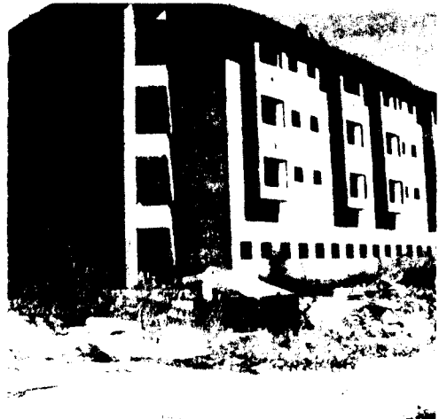
Lo scheletro del nuovo ospedale in località Castelnuovo
