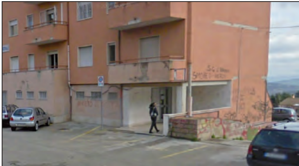
La vecchia sede in via Marche
