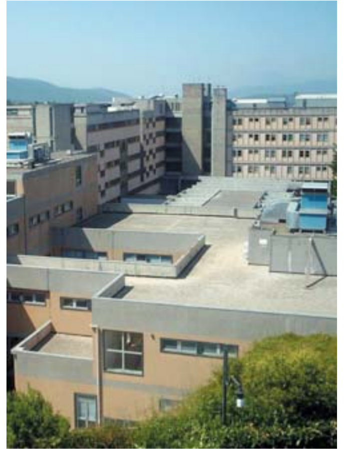
Ospedale Domani l'interruzione di energia elettrica
