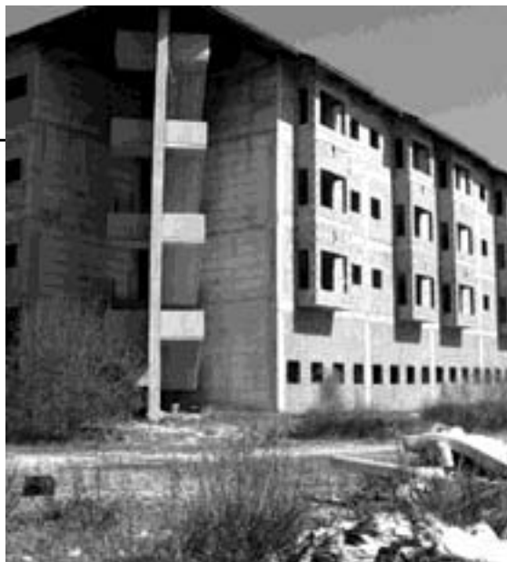
La nuova struttura costata già 10 miliardi delle vecchie lire
