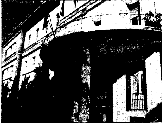
L'ex ingresso dell'ospedale con la terrazza danneggiata
